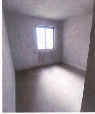
现状照片七：估价对象现状
